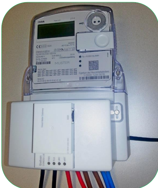
Bild 39: MT176 mit Gateway und GW Klemmendeckel
